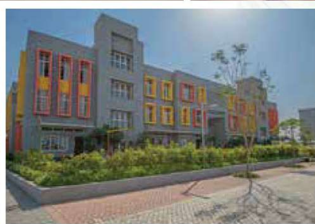
Actual site photographs
